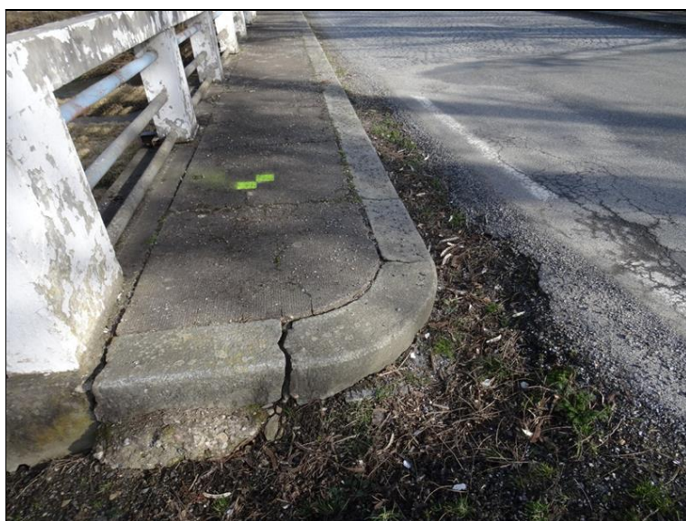
27.JPG Uvolněná obloukovou kamen. obruba na konci pravého chodníku. Rozpad zpevněné krajnice, na konci chodníku erozní rýha.
