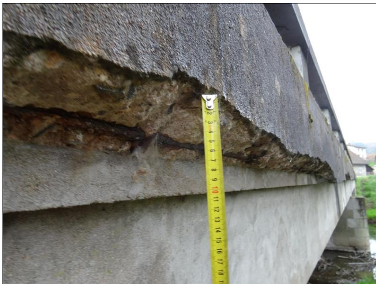
31.JPG Měřítka odpadu masy betonu v místě okapového nosu.
