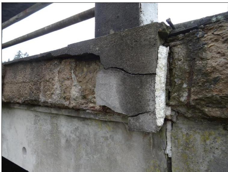
29.JPG Fasáda levé řimsy nad Op1. Odpad omítky, hloubková degr. betonu s obnaženou korodující výztuží.
