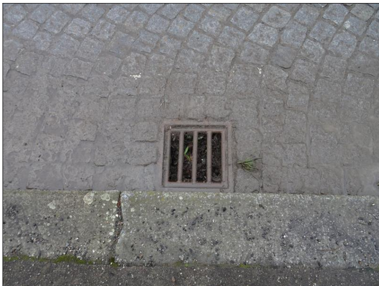
28.JPG Odvodňovač krytu vozovky v 1. poli (při levé straně vozovky). Zanesený nečistotami.
