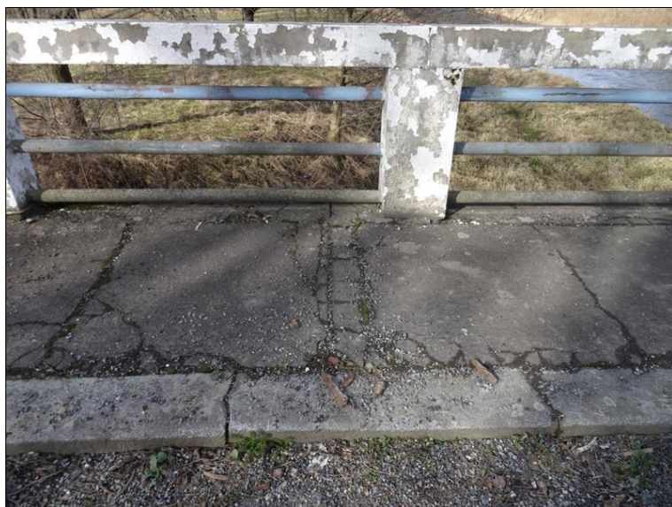
26.JPG Výsek pravého chodníku nad Op3 v místě PPD. Trhliny v pochozím povrchu chodníku.
