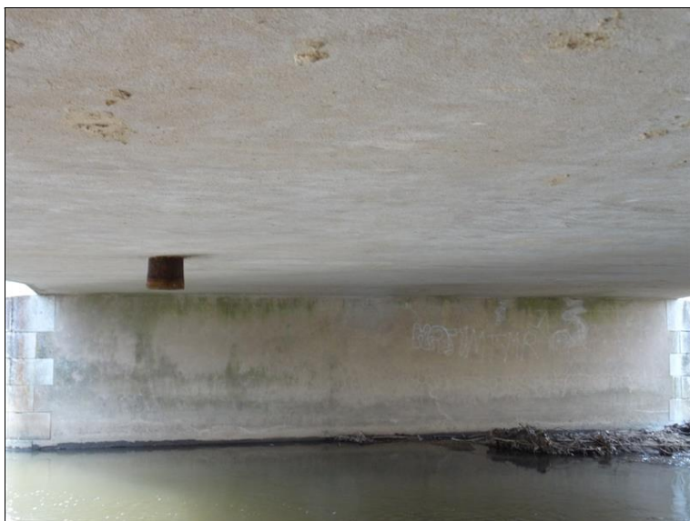
11.JPG Podhled NK v 1. poli ve směru pohledu ke středovému pilíři (P2). Celý podhled je opatřen omítkou.
