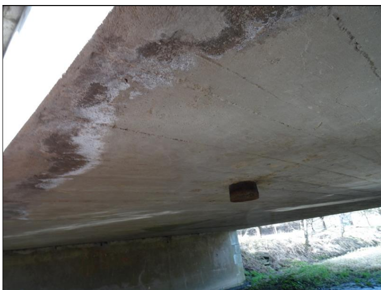
15.JPG Levá strana NK ve 2. mostním poli. Podélný kraj NK s výraznými mapami po zátocích do podhledu přes podřímsovou fasádu NK.
