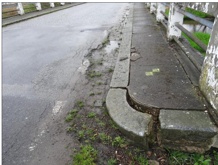
25.JPG Konec levého chodníku. Uvolněné koncové kamenné obruby. Rozpad krajnice živičného krytu v předpolí za Op3.
