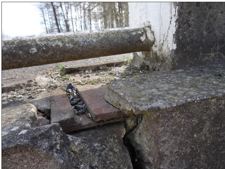
10.JPG Obnažená část PPD na vnějším kraji (v římse) pravého chodníku nad Op1.
