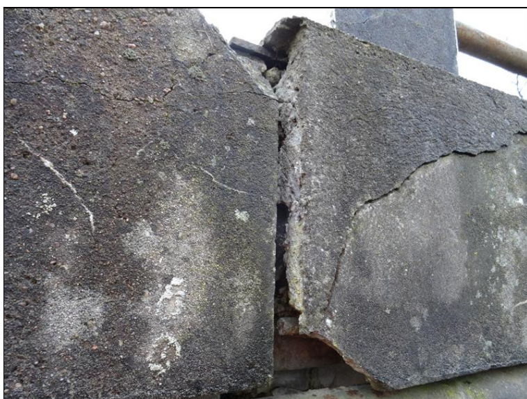
33.JPG Fasáda pravé římsy nad Op1. Separace omítky a degr. beton pod omítkou s lok. obnaženou výztuží.
