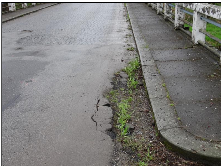
23.JPG Rozpadlý kryt pravé krajnice vozovky na začátku mostu před Op1.
