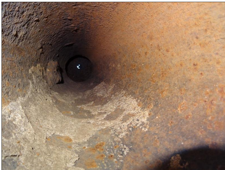
16.JPG Pohled na vnitřní povrch vyústění trubky odvodňovače ve 2. mostním poli.
