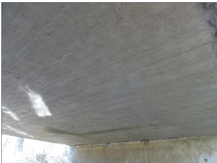
17.JPG Podhled NK v celkovém pohledu směrem k Op3. Před Op3 blíže k návodní straně je na pohledu NK patrná oblast s uchycenými řasami.
