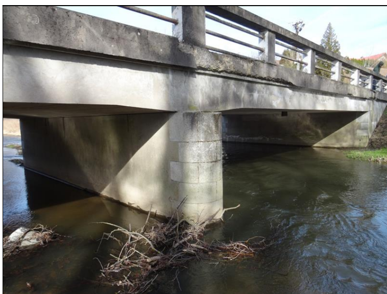
12.JPG Návodní strana mostu se zhlavím P2 v bližším pohledu. Odpad fasádní omítky římse na konci 1. pole před P2.
