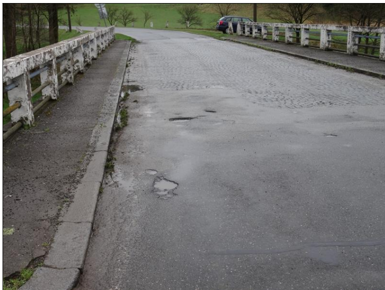
22.JPG Živičná úprava předpolí s přesahem od mostu na straně Op1.
