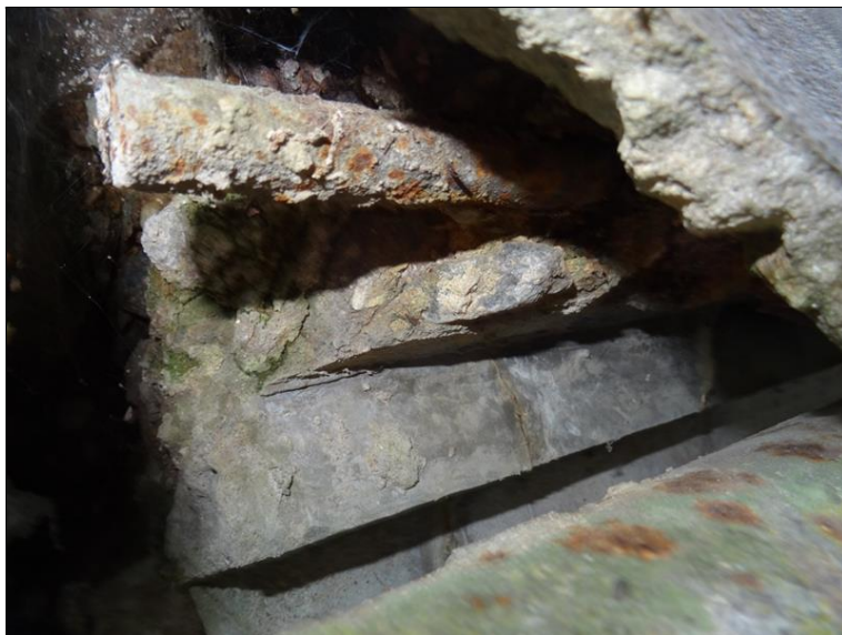
34.JPG Detail obnažené výztuže v degr. betonu pod separ. omítkou.
