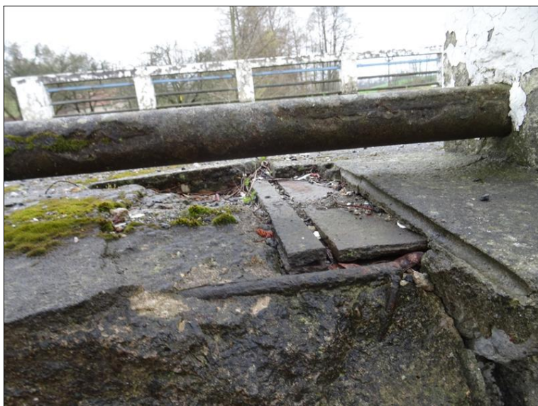
20.JPG Obnažená část PPD na vnějším kraji (v římse) levého chodníku nad Op3.
