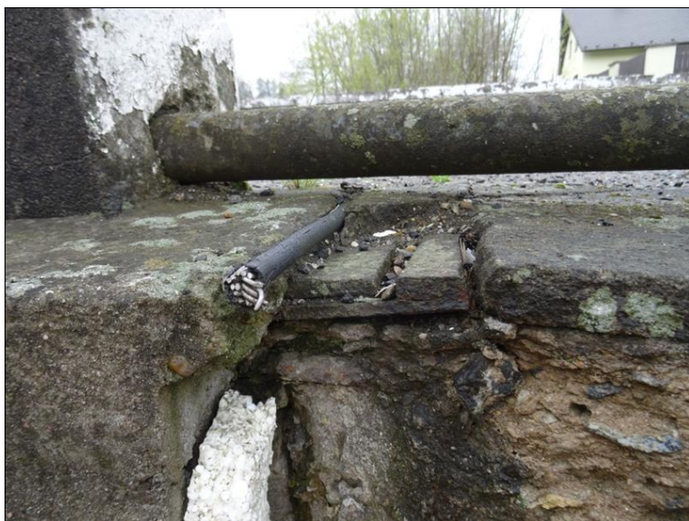
8.JPG Obnažená část podpovrchové dilatace (PPD) na vnějším kraji (v římse) levého chodníku nad Op1.
