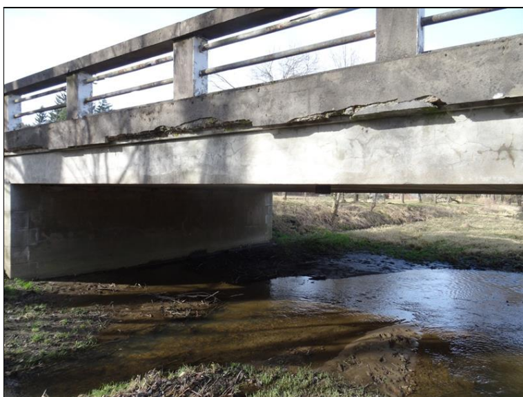
30.JPG Fasáda levé řimsy ve 2. poli. Opad okapového nosu.
